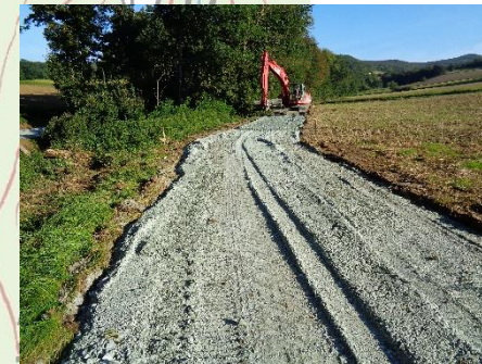
Errichtung von Wegen
