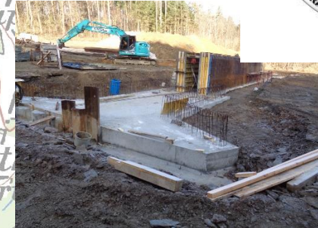
Flächenmanagement für Hochwasserschutzdamm
