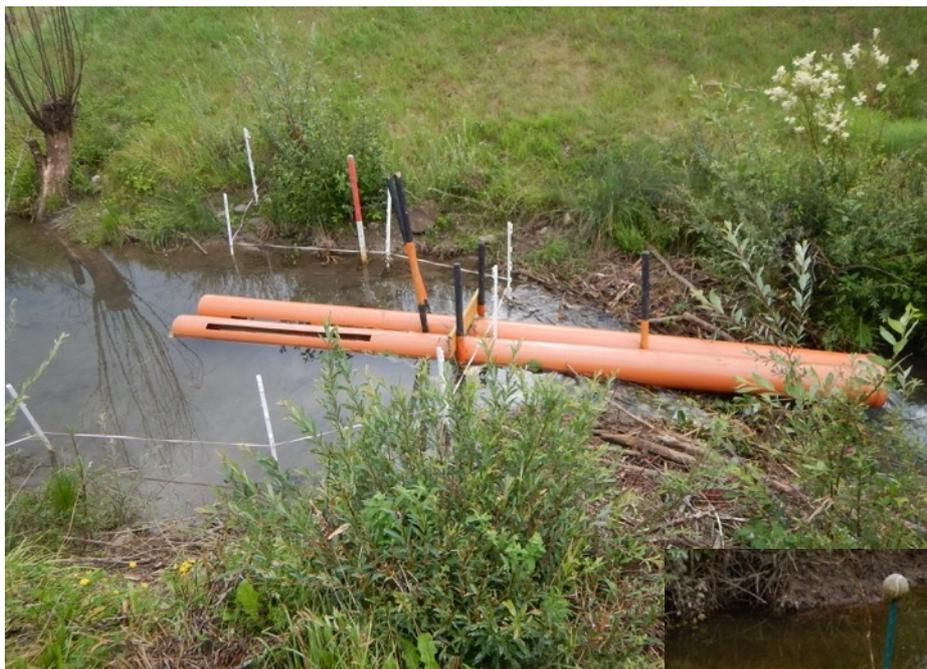
Abbildung 6: Kombination Dammdrainage mit Schlitzen und E-Zaun © C.Trixner
