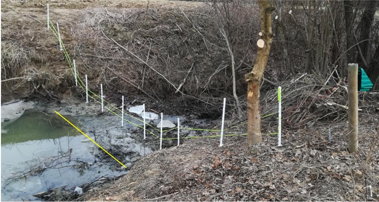
Abbildung 8: Steher mit Litze möglichst am Dammbeginn (gelbe Linie); Pfähle werden enger gesetzt © B.Skopec
