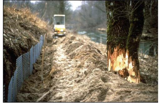
Abbildung 7: Drahtgitter vertikal eingegraben (SCHWAB 2014, Foto: Lossow)
