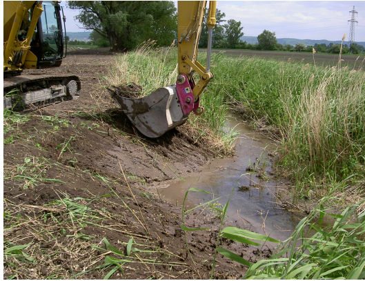
Abb. 57: Erhöhung der Struktur am Kanalgraben
