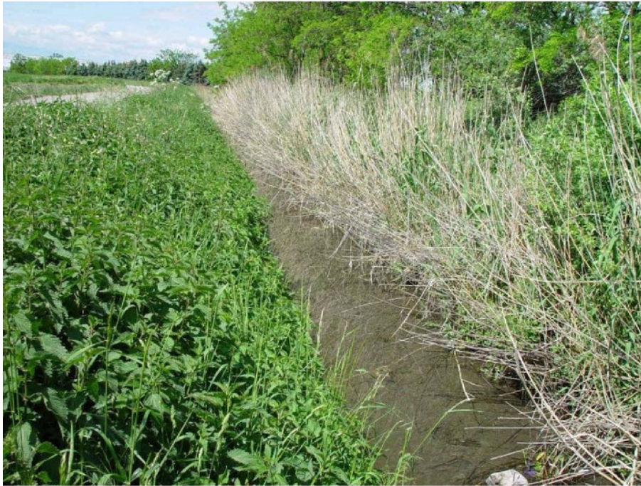
Abb. 15: Kanalgraben, Abschnitt K2
