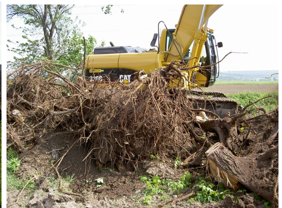
Abb. 56: Entfernung der Wurzelstöcke
