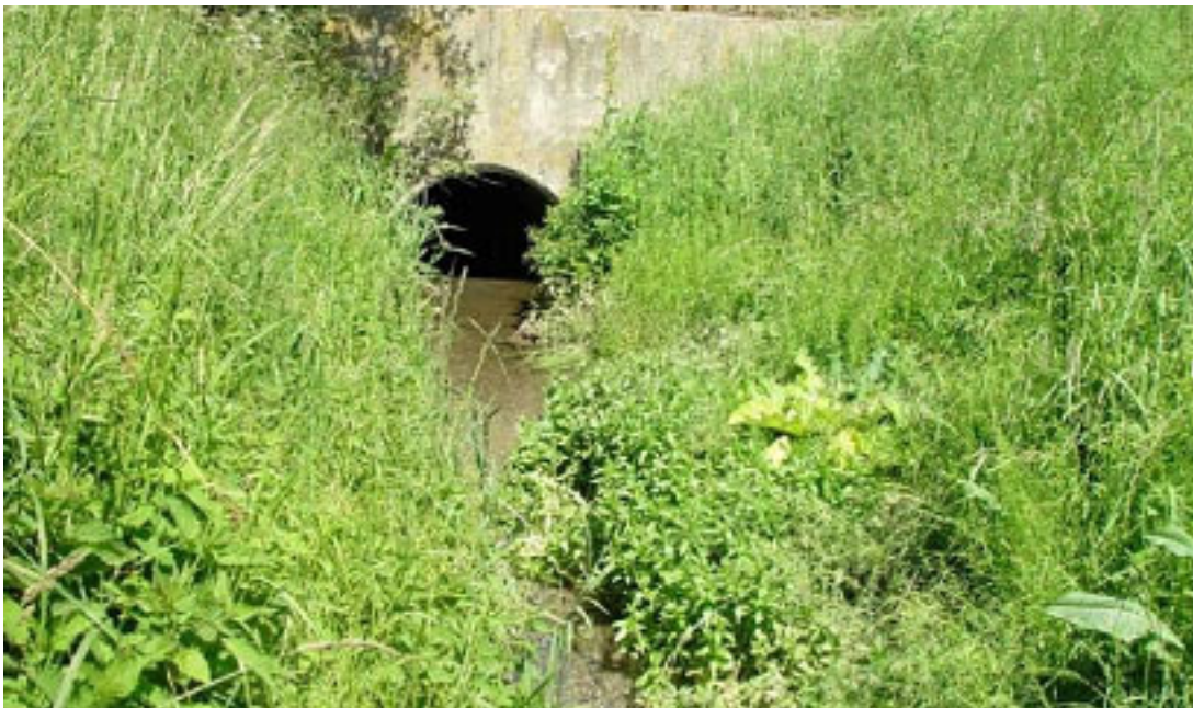
Abb. 14: Kanalgraben, Abschnitt K1
