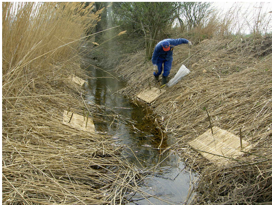
Abb. 51: Anbringen der Weidenstecklinge in den ausgelegten Schilfmatten
