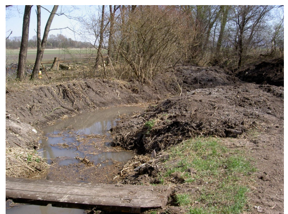
Abb. 65: Nach Entfernung der Betonschalen
